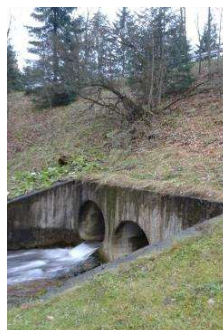
Bariera ekologiczna na Małoląckim Potoku. Przepust nad drogą wojewódzką
