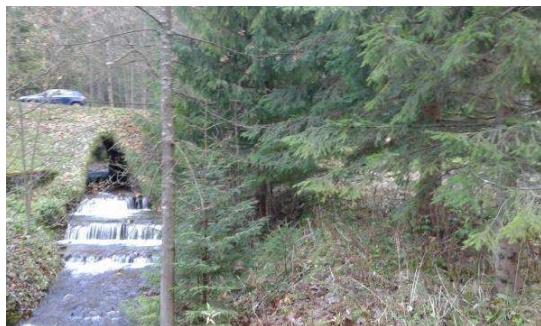
Przepust pod starą drogą
