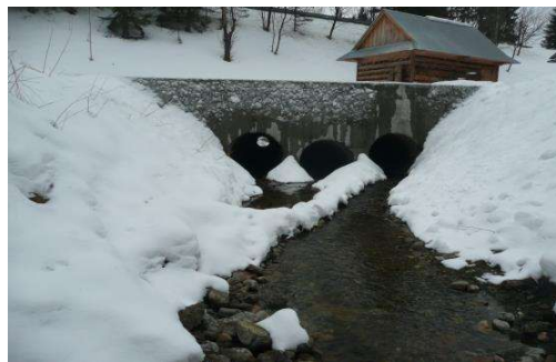
Przepust pod drogą wojewódzka
